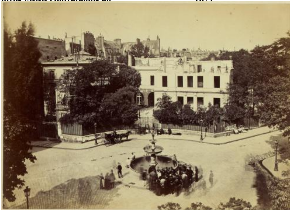
Maison de Thiers en cours de démolition.
