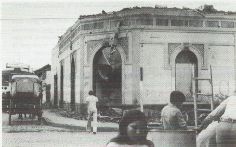
Destruction en juin 1979 à Massaya dans le centre ville.
